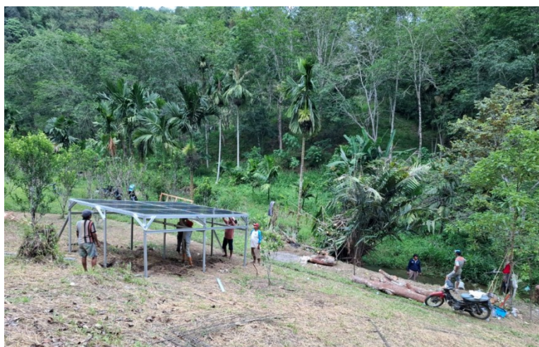
Gambar 1. Pembangunan Solar di Lokasi
