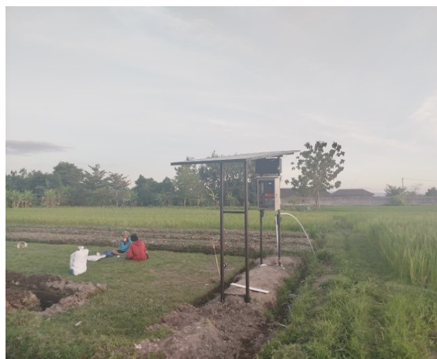
Gambar 8. Penerapan Teknologi Irigasi Tenaga Surya Berbasis IoT
