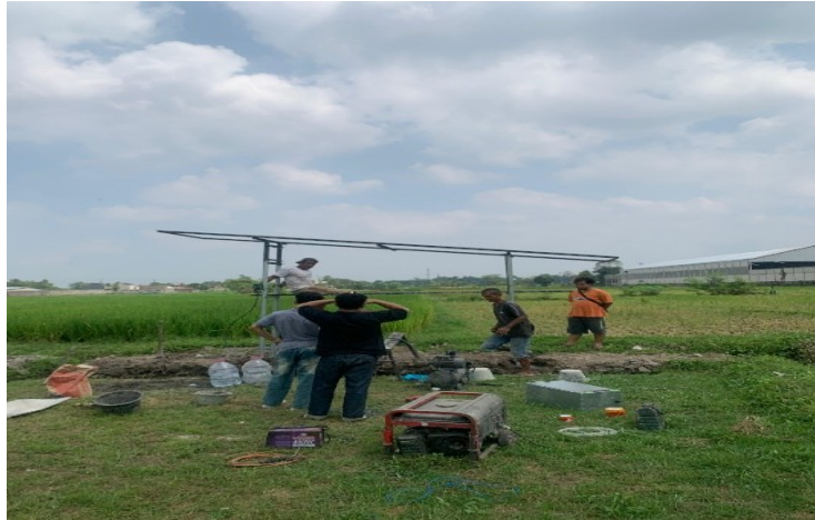
Gambar 4. Pemasangan Rangka Pada Lahan Pertanian
