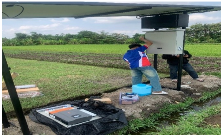
Gambar 5. Pemasangan Panel Surya Dan Panel Box Pada Lahan Pertanian
