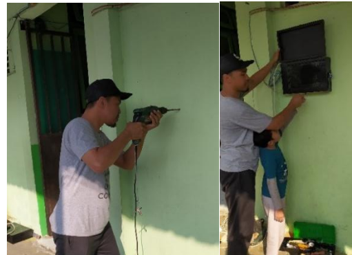
Gambar 10. Pemasangan Bracket Pelindung Perangkat
