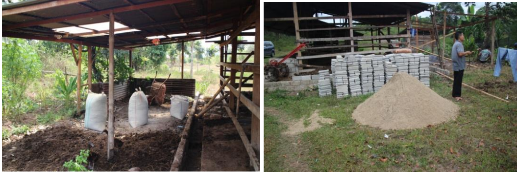
Gambar 1. Foto Material dan Proses Perombakan Tempat Pengampungan Kotoran
