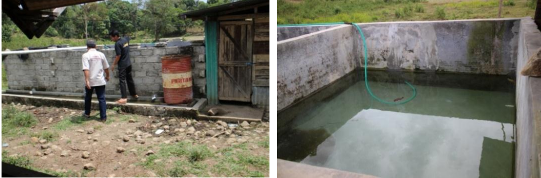
Gambar 3. Perbaikan Bak Penampung Air di Kelompok Mitra
